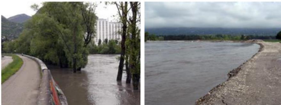
Figure 77 : Meylan, Ile d'Amour et Isère amont, courbe de Charlet (photos : AD Isère)
