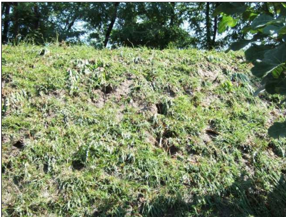
Figure 79 : Début de renard hydraulique RG en amont de la brèche
