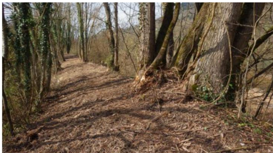
Figure 35 : Bois Jolivet A : Vue en crête du profil de digue – CNR
