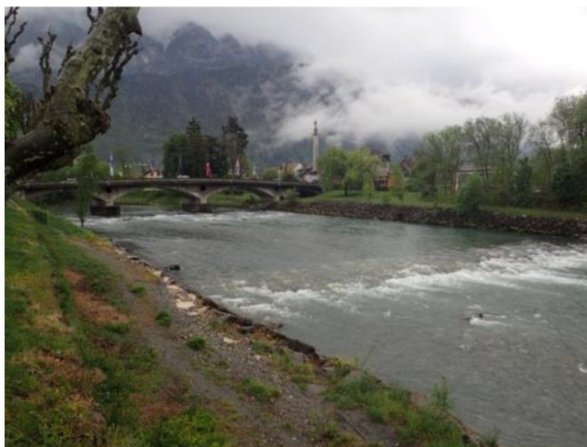
Figure 46 : Seuil aval au pont de l'Europe, vue vers l'amont - CNR
