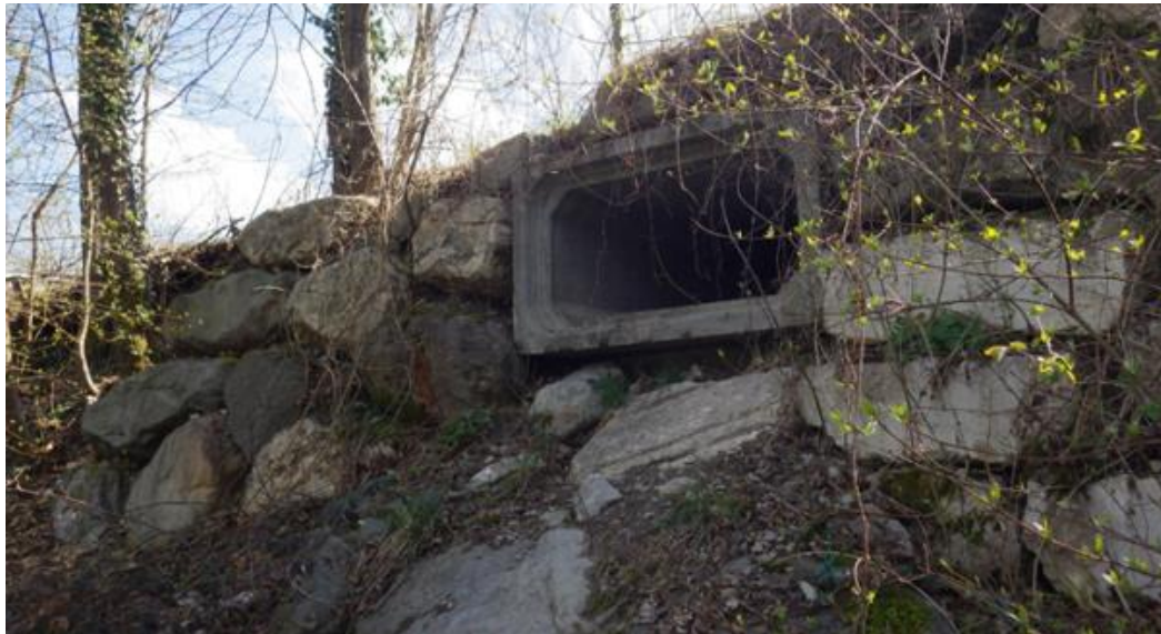
Figure 13 : Castorduc traversant l'ouvrage RD19 (VTA CNR 2017)
