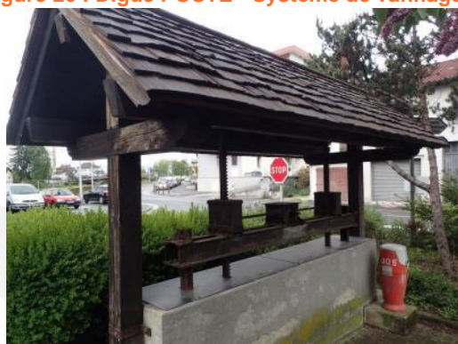
Figure 26 : Digue POSTE - Système de vannage de la Madeleine
