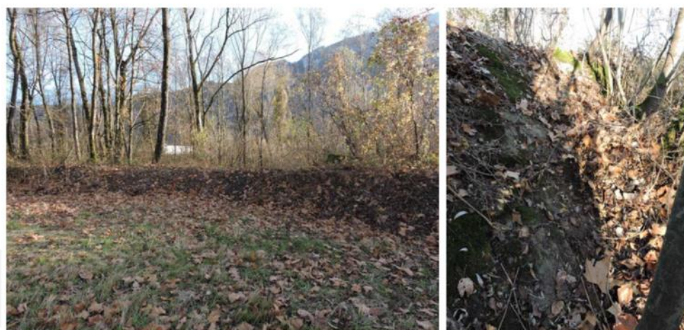
Figure 17 : Photos de la digue du Bouchet T02, partie amont de la vanne Décret
