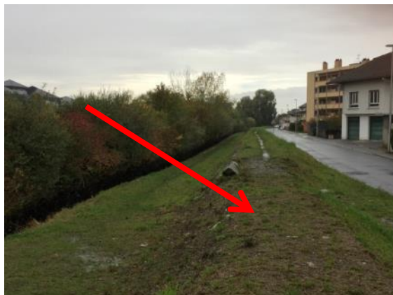
Figure 24 : Digue JB REY - Confortement grossier de la digue
