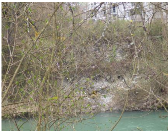
Figure 42 : Trésor Public T01 - Talus érodé sub-vertical
