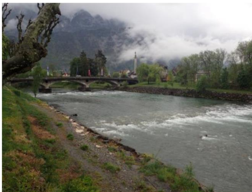
Figure 49 : Seuil aval au pont de l'Europe, vue vers l'amont - CNR
