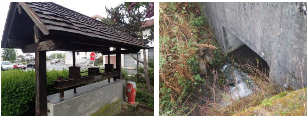
Figure 160 : Vanne de régulation du ruisseau de la Madeleine, et exutoire en rive droite de l'Arve
