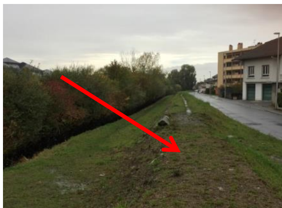
Figure 36 : Digue JB REY - Confortement grossier de la digue
