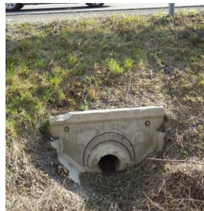
Un exutoire du réseau de drainage
