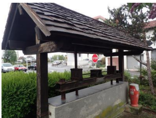
Vanne de régulation du ruisseau de la Madeleine
