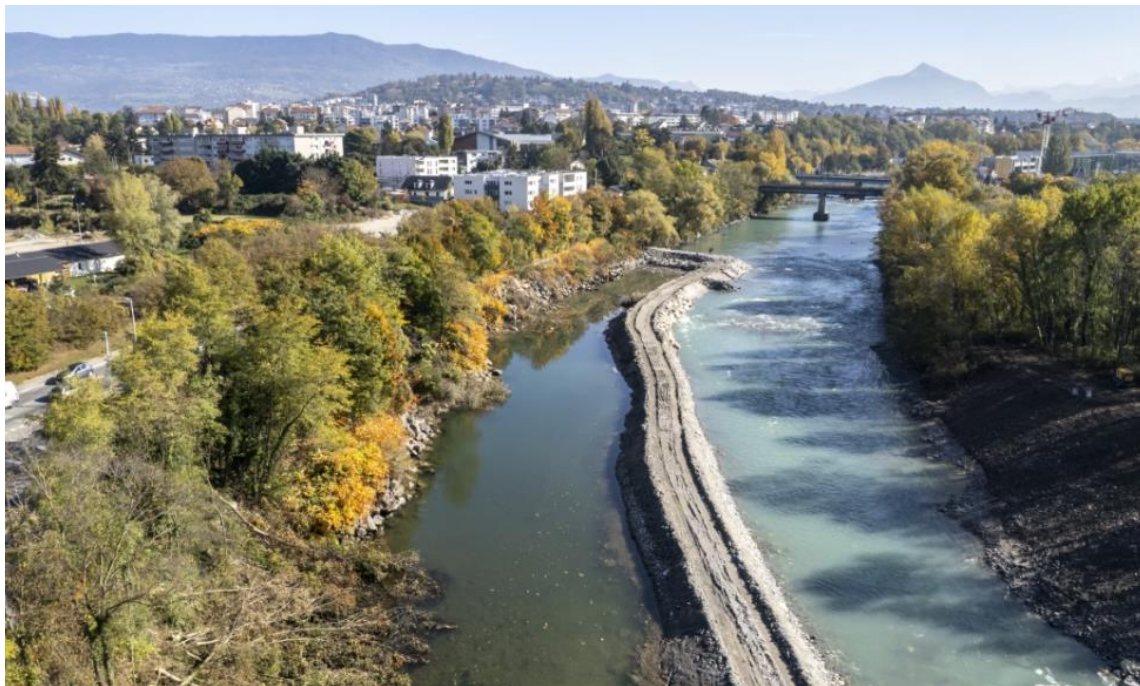
Figure 29 : Illustration d'un batardeau classique
