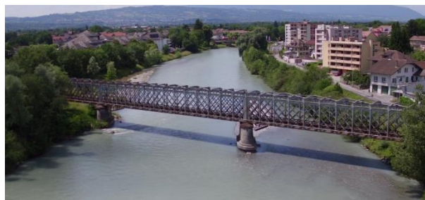
Pont de la voie ferrée.
