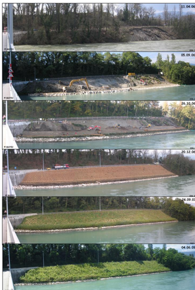
Figure 23 : Illustrations successives de la protection mixte enrochements-lits de plants et plançons-plantations mise en place en rive gauche du Rhône à Avully (Suisse) en soutènement d'une route (conception, photos et suivi des travaux : Biotec en collaboration avec GEOS
