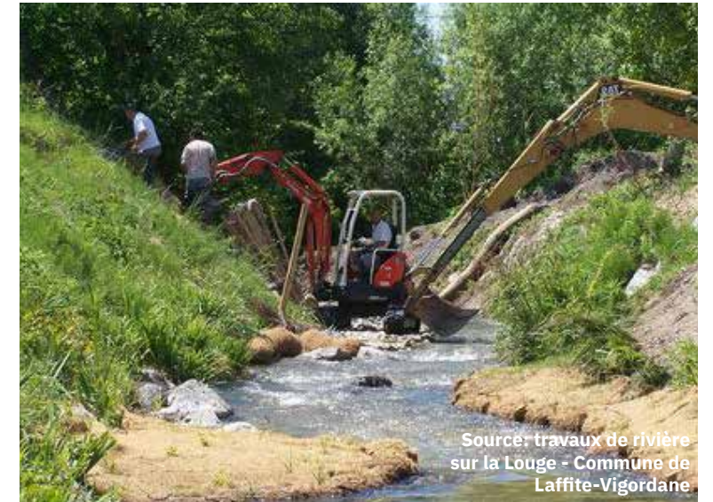
Modelage des berges pour recréer la forme d'un cours d'eau
