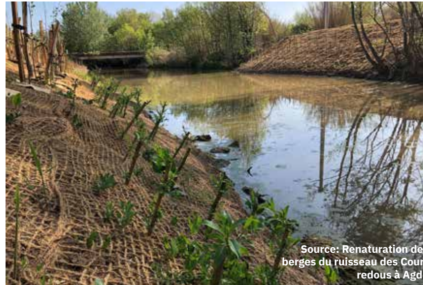
Les berges seront modelées et plantées grâce aux bionattes préensemencées par un mélange grainier adapté à chaque niveau d'immersion
