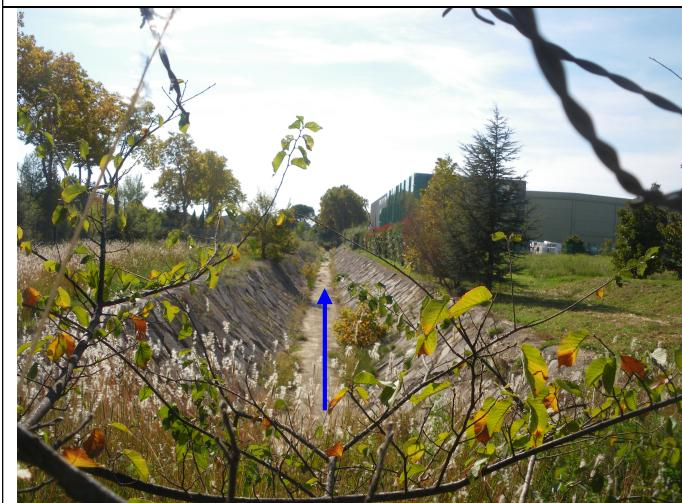
Photo 5 : Profil trapézoïdal du cours d'eau avec enrochements
