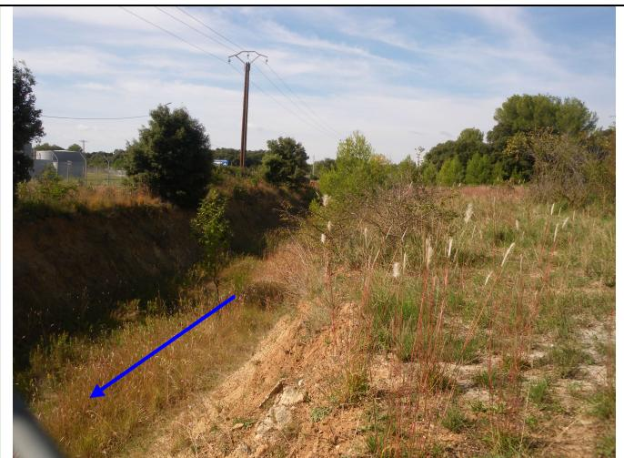
Photo 2 : Profil trapézoïdal en terre du cours d'eau
