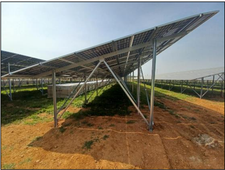
Figure 15 - Exemple d'une table photovoltaïque (Source : ELEMENTS).
