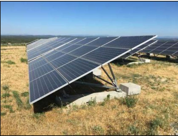
Figure 20 – Photographies de gabions et de longrines en béton (Source : ELEMENTS).
