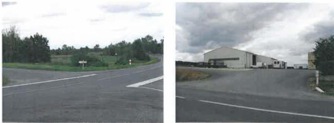
Ci-dessus, deux accès délicats en terme de sécurité sur la R.D 938ter, sur la photo de gauche, l'intersection permet de rejoindre le hameau du Bas des Vignes ou les Serres de Challon, à droite il s'agit de la coopérative agricole située au bord de la voie.
