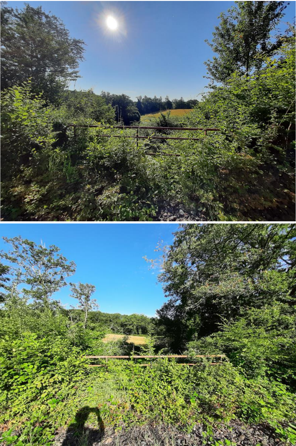
Figure 1 : Photos de l'ouvrage d'art permettant le passage du cours d'eau Le Budelière sous l'ouvrage de la voie ferrée (DCI Environnement)
