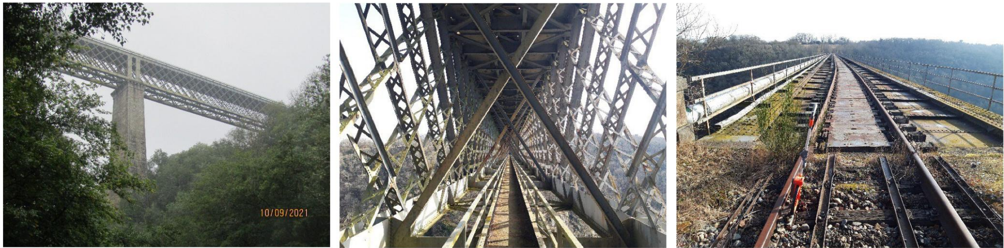
Ouvrage métallique treillis
