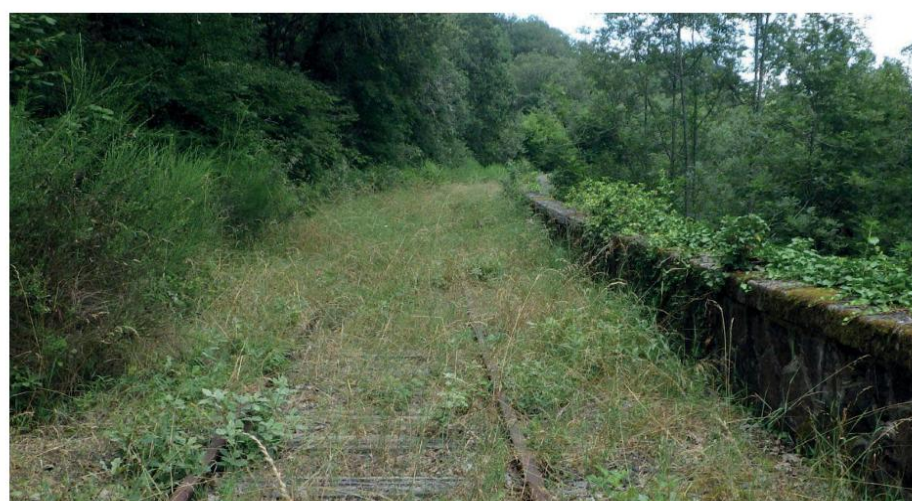
Photo sur site du profil existant
