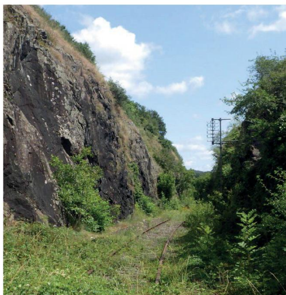
Photo sur site du profil existant
