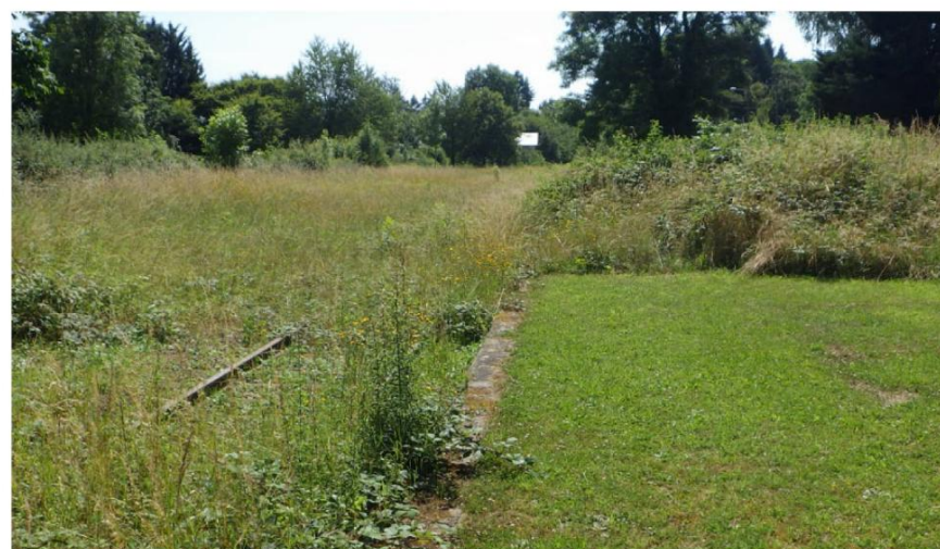
Photo sur site du profil existant
