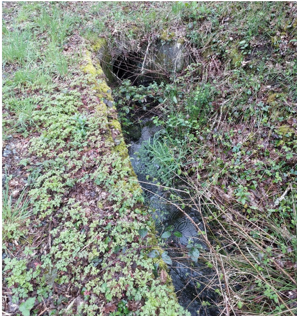
Fossé artificiel dans les accotements de la voie ferrée
