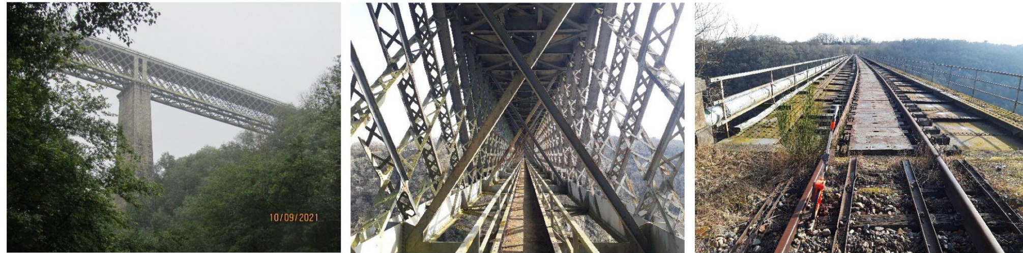
Ouvrage métallique treillis
