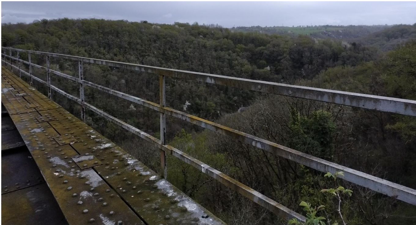
Viaduc passant au-dessus de la Tardes
