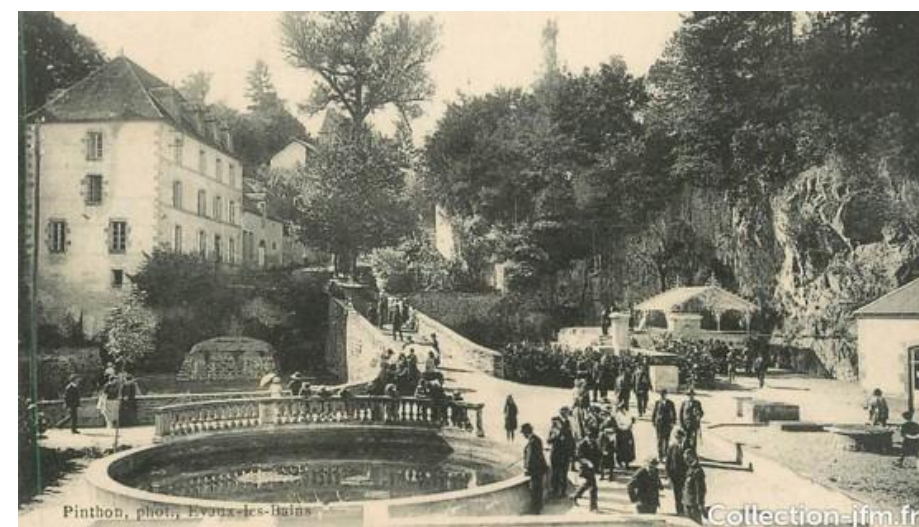
Figure 4 : Carte postale ancienne - Les sources de l'établissement thermal
