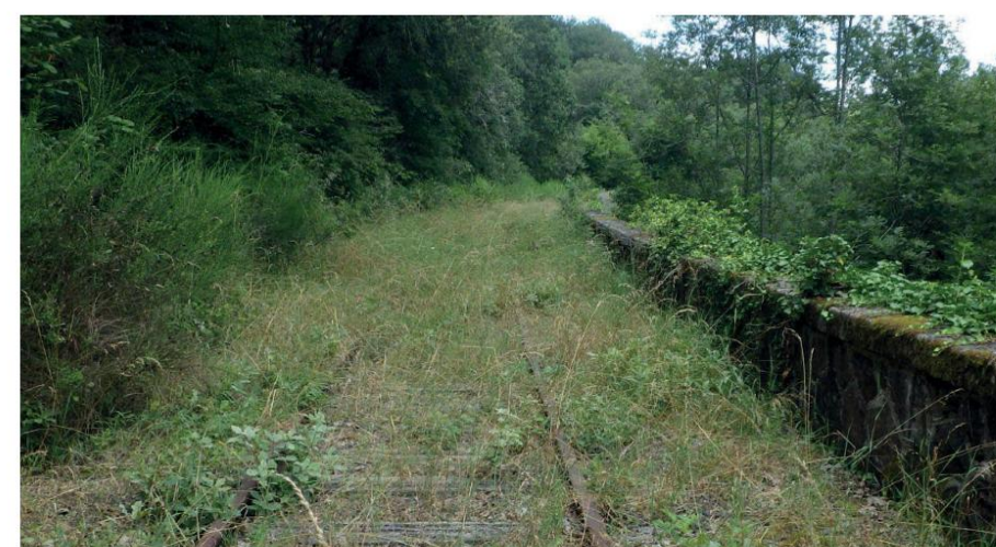
Photo sur site du profil existant
