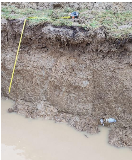
Figure 24 : Présence d'un drain en fond de tranchée
