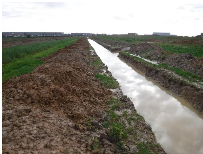
Figure 23 : Excès d'eau observés dans les tranchées destinées aux investigations archéologiques (source : FLOW-concept, 30/12/2021)
