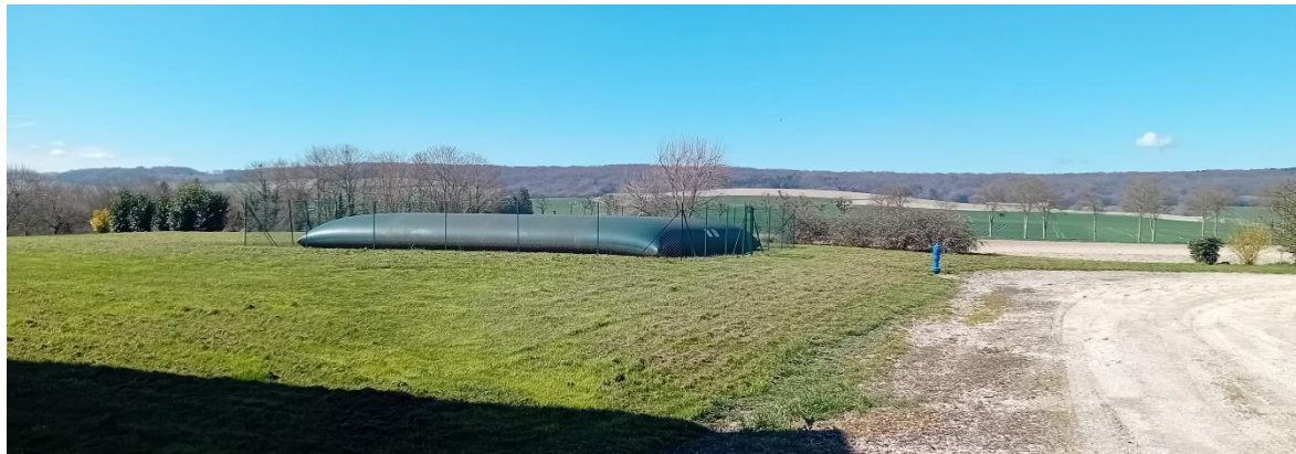
Poche incendie existante avec borne de pompage
