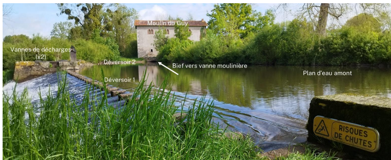
Figure 4 : Composition du complexe hydraulique « Moulin du Guy » (source : FLOW-concept)
