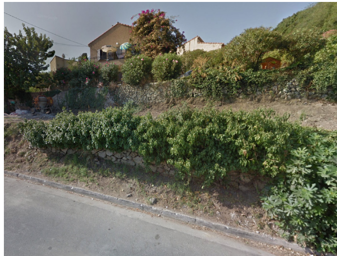
Des murets de pierres sèches qui se dégradent
