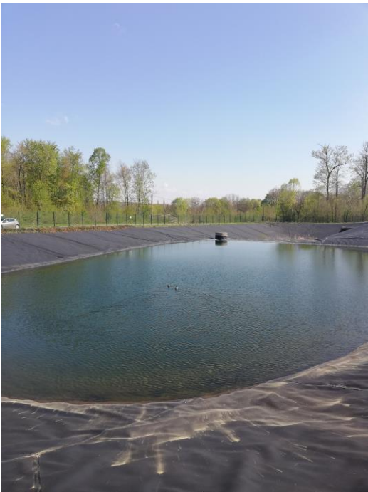
PHOTOGRAPHIE 14 : BASSIN TECHNIQUE DE GESTION DES EAUX PLUVIALES (©EGIS AVRIL 2023)
