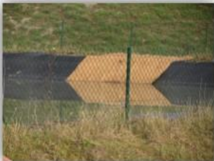
PHOTOGRAPHIE 17 : RAMPE DE SORTIE EXISTANTE SUR LE BASSIN DE GESTION DES EAUX PLUVIALES SITUÉS LE LONG DE LA RD 6
