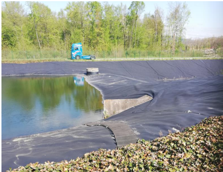
PHOTOGRAPHIE 17 : RAMPE DE SORTIE EXISTANTE SUR LE BASSIN DE GESTION DES EAUX PLUVIALES SITUÉS LE LONG DE LA RD 6
