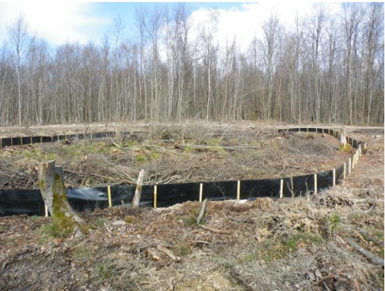
PHOTOGRAPHIE 19 : VUE D'UN DISPOSITIF DE CLÔTURE TEMPORAIRE EN BÂCHE (©ECOLOR)
