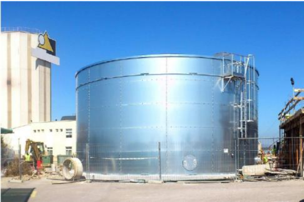
FIGURE 47 : CUVE DE STOCKAGE DES EAUX DE DÉFENSE INCENDIE (SOURCE : MÉMOIRE TECHNIQUE OTE, JUIN 2024)
