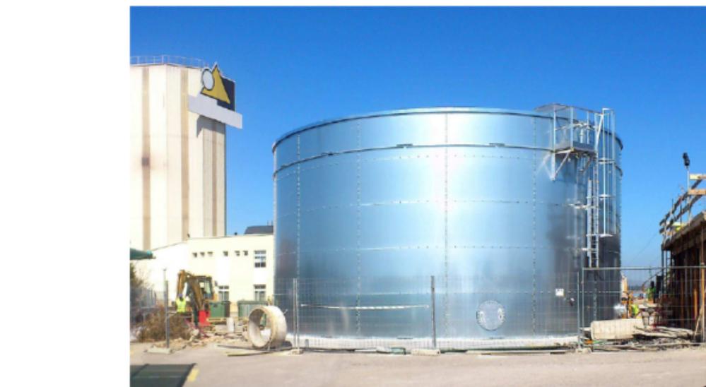
FIGURE 42 : CUVE DE STOCKAGE DES EAUX DE DEFENSE INCENDIE (SOURCE : MEMOIRE TECHNIQUE OTE, JUIN 2024)
