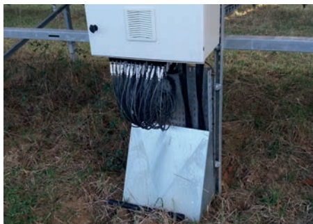
Photos 64 : Présence de câble à 50cm de haut, risque d'endommagement de la structure sans protection (© Idelle)
