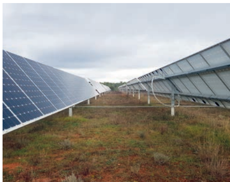
Photo 18 : Barres de commandes de panneaux trackers 1 axe pouvant éventuellement compliquer la co-activité avec l'élevage selon leur hauteur (si < 80 cm du sol) (© Idelle)
