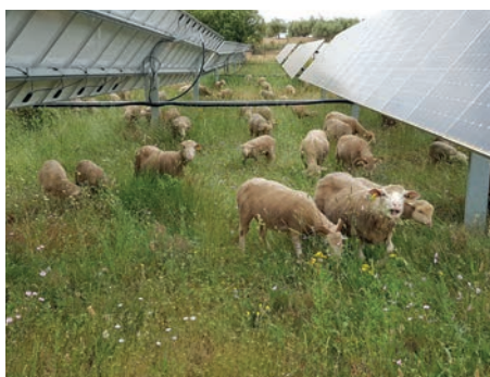
Photo 19 : Les barres de commandes de trackers 1 axe ne posent pas de problèmes si les animaux peuvent circuler de façon fluide au-dessous, comme dans la centrale du Canadel (83) (© Voltaïa)
