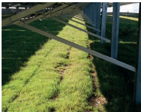
Photo 32 : Table fixe sur mono-pieu battu (© Idele)
