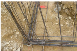
Nœud de chaînage - Continuité mécanique
