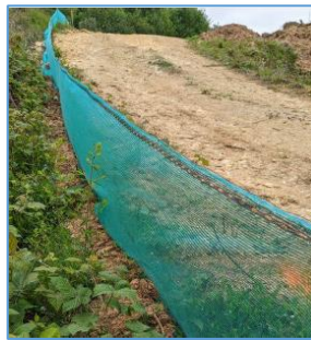
Filet "anti-intrusion" pour éviter le passage de la faune sur le chantier
