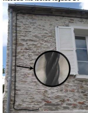
Réseau fils isolés façade BT
