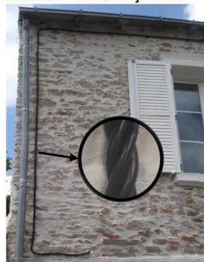
Réseau fils isolés façade BT
