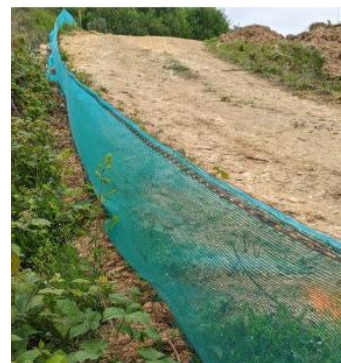
Figure 42. Filet "anti-intrusion" pour éviter le passage de la faune sur le chantier
