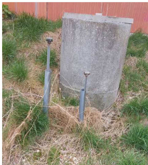
Photo 5.2 : Vannes d'orientation des lisiers vers les ouvrages de stockage
