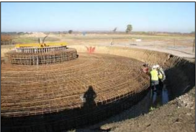
Photo 12 : Ferrailage de la fondation
