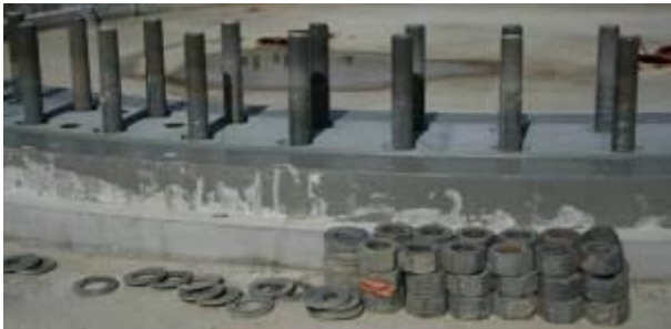
Photo 3 : Détail des fixations de la fondation
