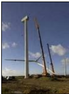
Photo 20 : Hissage et assemblage du rotor
