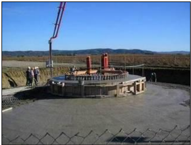
Photo 13 : Coulage du béton
