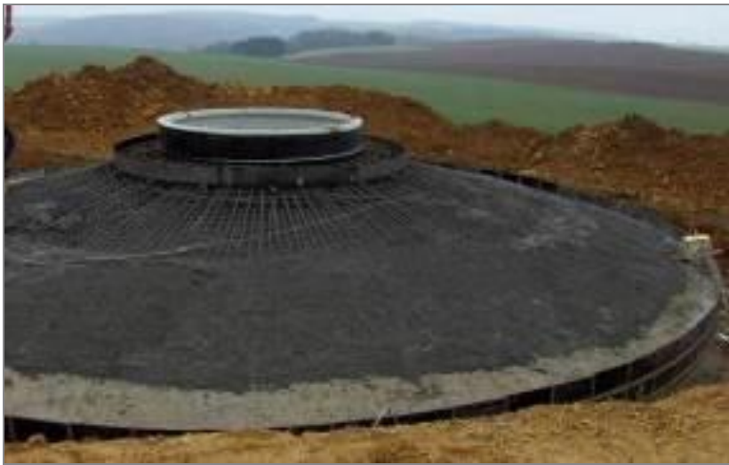
Photo 1 : Exemple de ferraillage en radier pour une éolienne
