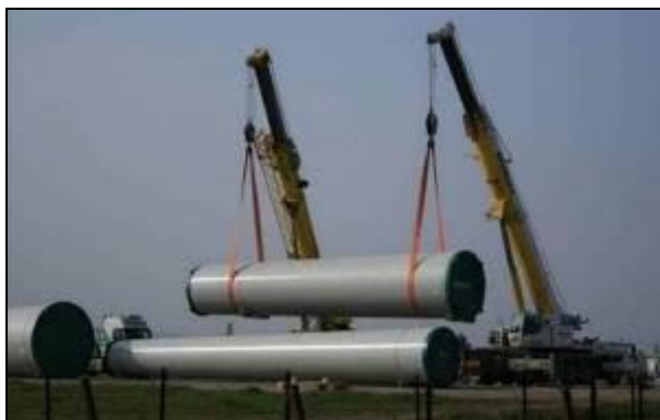
Photo 16 : Manipulation des tronçons d'éoliennes
