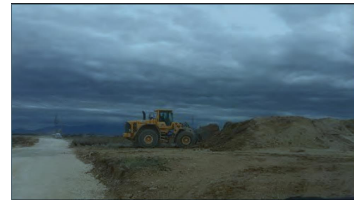
Figure 17 : Reprise de la terre stockée pour le remblayage des fondations ; Source : Abies, suivi de chantier éolien
