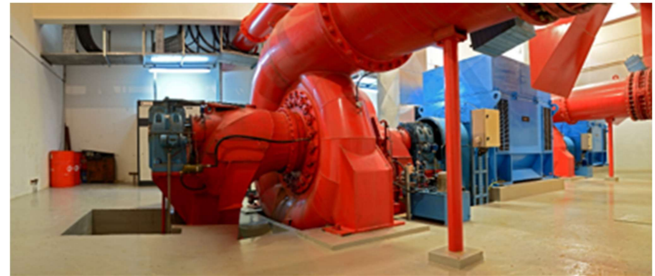
Figure 10 : Illustration de turbines de centrale hydroélectrique
