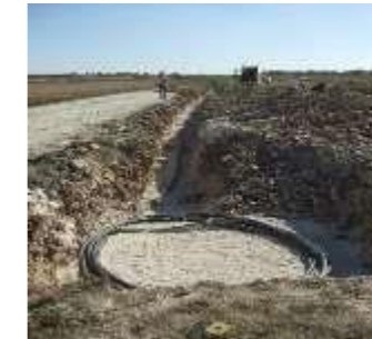
Pose de réseaux HTA
