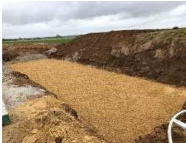
Figure 5 : Exemple de fond de fouille pour poste de livraison éolien.
