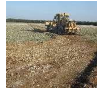
Décapage pour câblage
