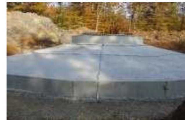
Figure 2 : Massif d'éolienne avec ceinture équipotentielle pour MALT
