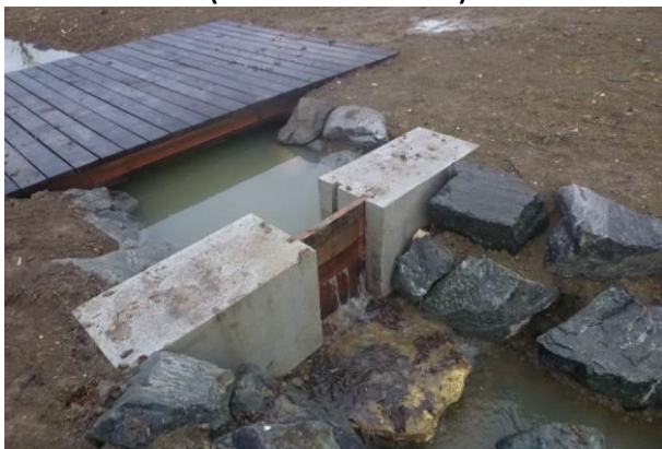
Exemples d'un ouvrage de cloisonnement entre l'étang et la zone humide surmontée d'une passerelle bois (Srce : BET LEGRAND)
