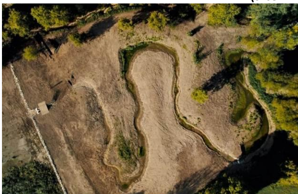
Vue aérienne de travaux de création d'une zone humide en queue d'étang – Mai 2024 (Srce : SMVA)
