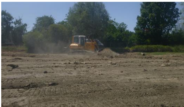
Travaux de curage d'un étang en cours (Srce : BET LEGRAND)
