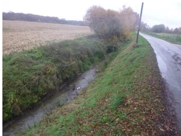
Vue du fossé avant sa confluence avec la Sange
