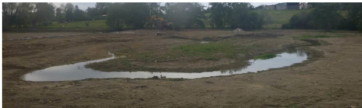
Exemple d'une zone humide en queue d'étang – Octobre 2023 (fin des travaux de régalinge des sédiments) (Srce : BET LEGRAND)
