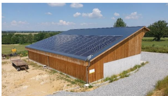
Figure 40 : Photo d'un séchoir fourrage + céréales + bois. 100% alimenté en air chaud par la toiture solaire. (Agonges – 03) (Source : AS DEV.)
