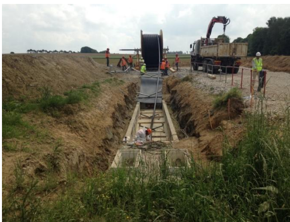
Chambre de jonction et puits de terre au premier plan
