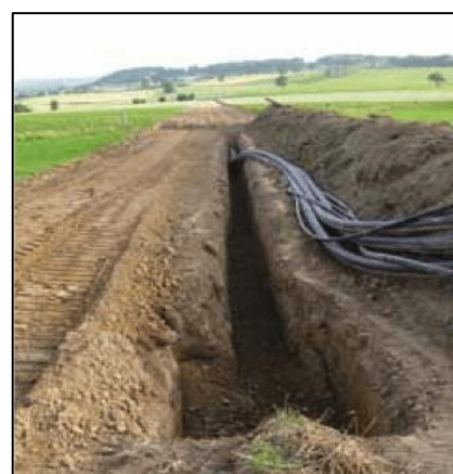
souterraine en technique 225 000 volts (pose en trèfle)
