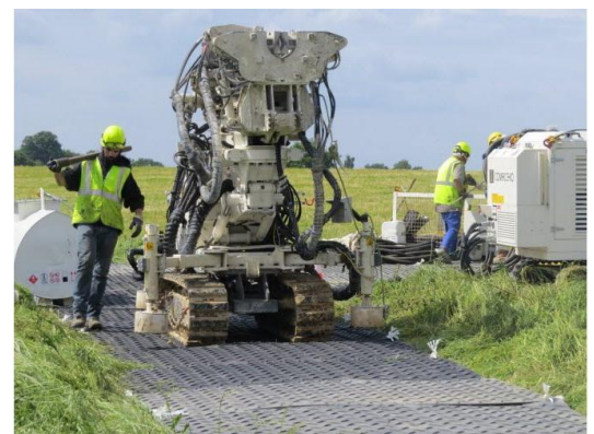
Circulation d'engin sur plaques.
