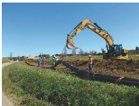
Pose des fourreaux PEHD en pleine terre.
