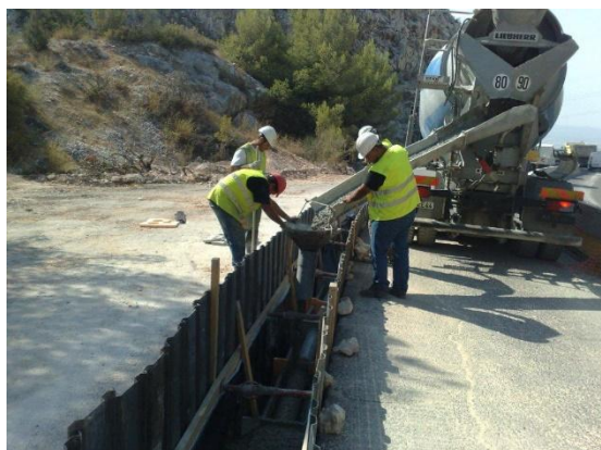
Coulage du béton.
