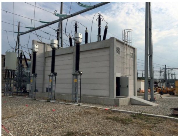
Exemple de SELF de compensation 225 000 volts
