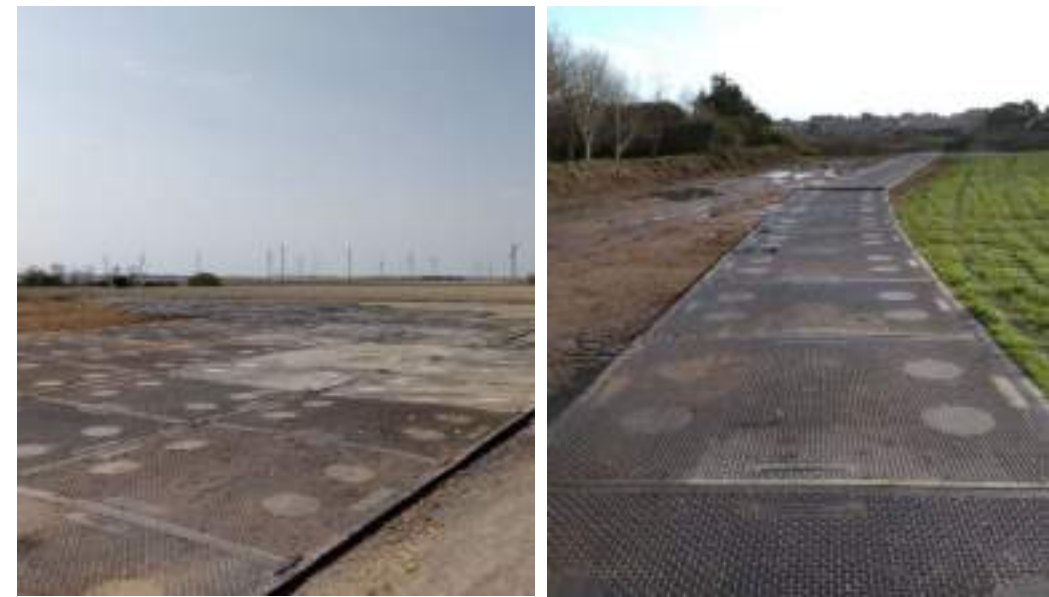
Plaques de répartition de charge (source : TSPS)
