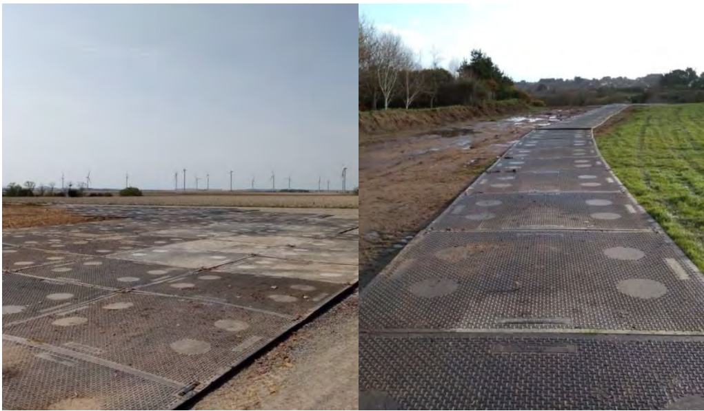
Figure 105. Plaques de répartition de charge (source : TSPS)
