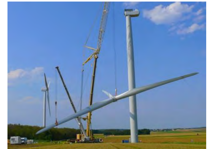
Figure 90 : Hissage du rotor complet
