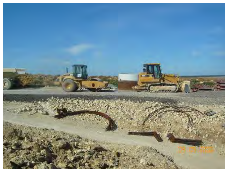
Figure 81 : Aplanissement du terrain
