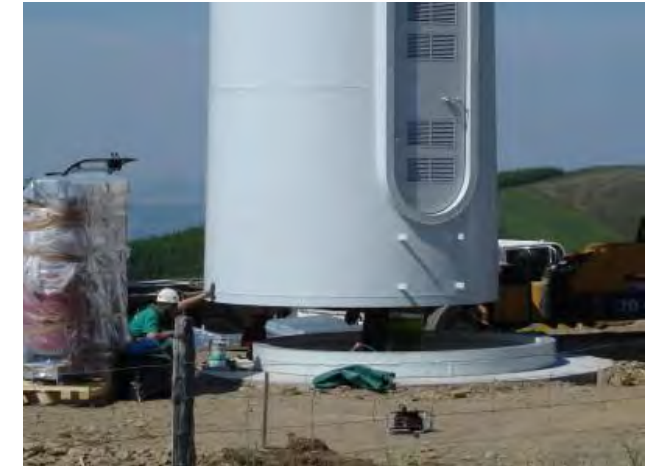
Figure 86 : Assemblage de la première section de la tour
