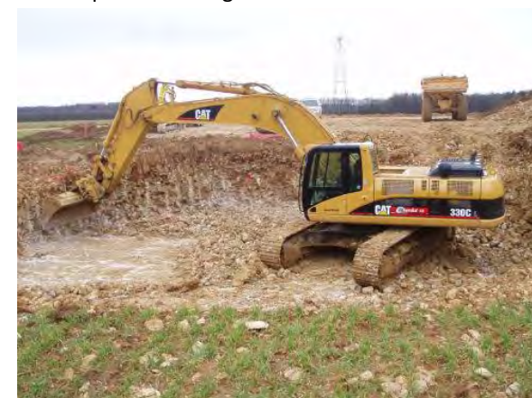
Figure 83 : Fouille de la fondation
