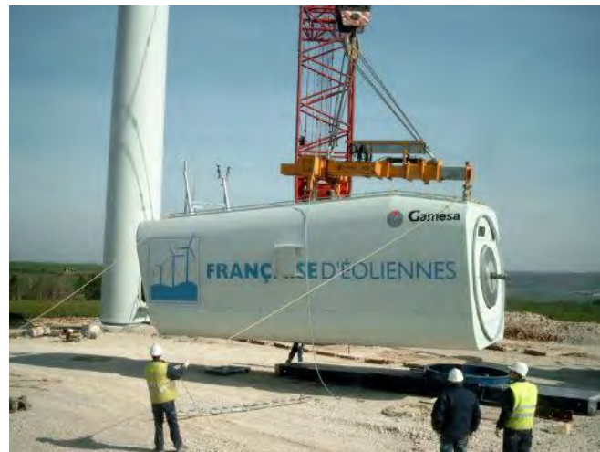
Figure 88 : Hissage de la nacelle
