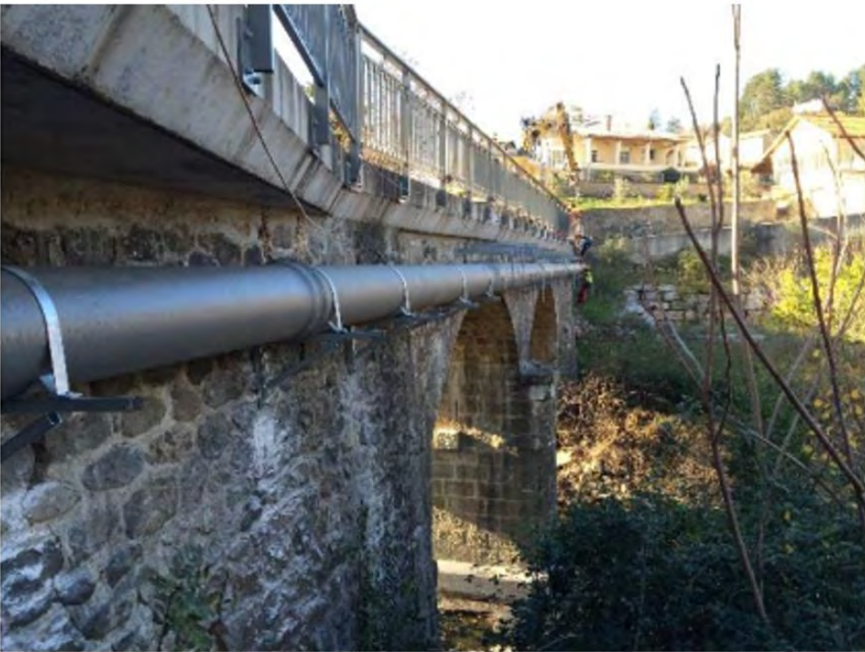
Figure 102 : Exemple d’encorbellement (source : rampa-tp.com)
