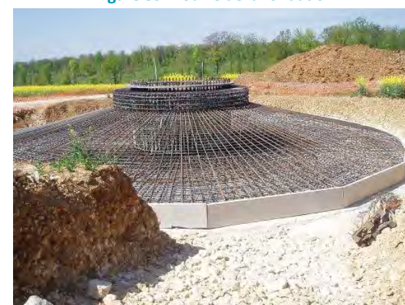
Figure 84 : Ferrailage de la fondation
