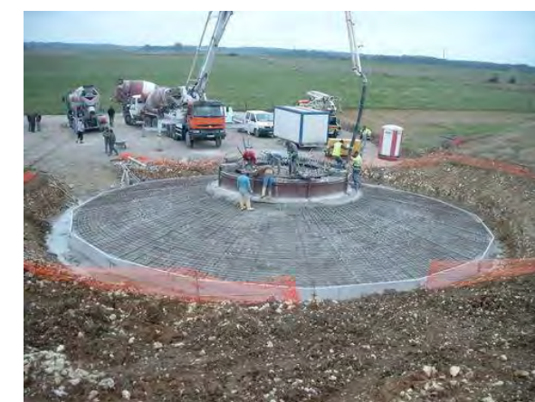
Figure 84 : Ferrailage de la fondation
