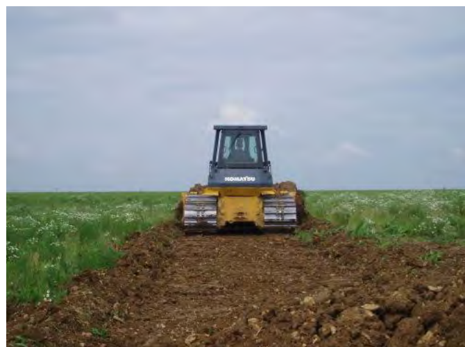
Figure 82 : Mise en forme des chemins d'accès
