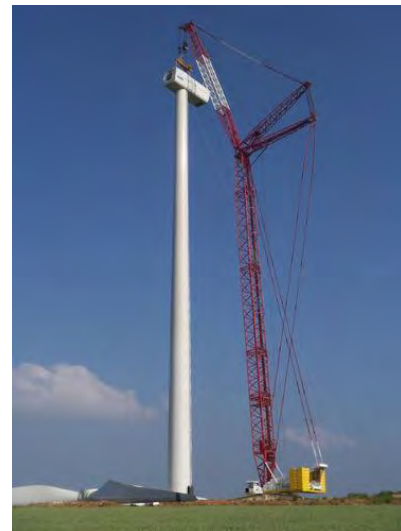
Figure 89 : Fixation de la nacelle sur la tour
