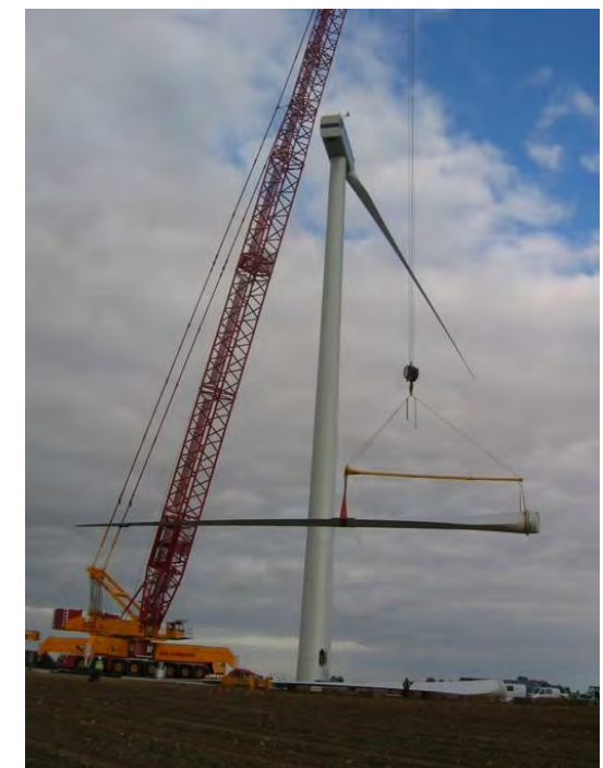
Figure 91 : Système de levage d'une pale
