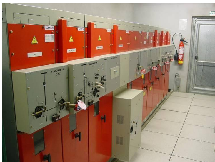
Figure 15 : Intérieur d'un poste de livraison (Source : VALECO)
