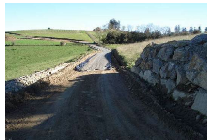
Illustration 24 : Mise en place du gravier
