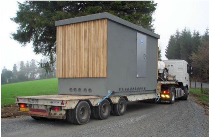
Illustration 14 : Arrivée d'un poste de livraison sur un site éolien
