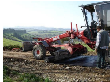
Illustration 23 : Pose du géotextile
