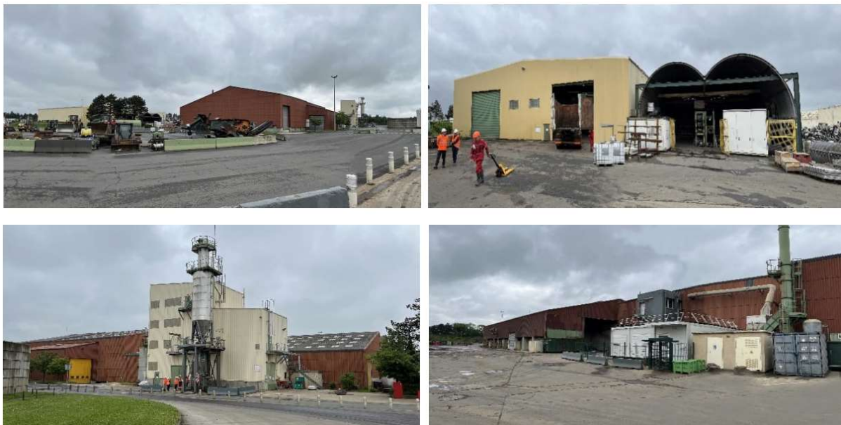
Figure 121 : Photos du site actuel
