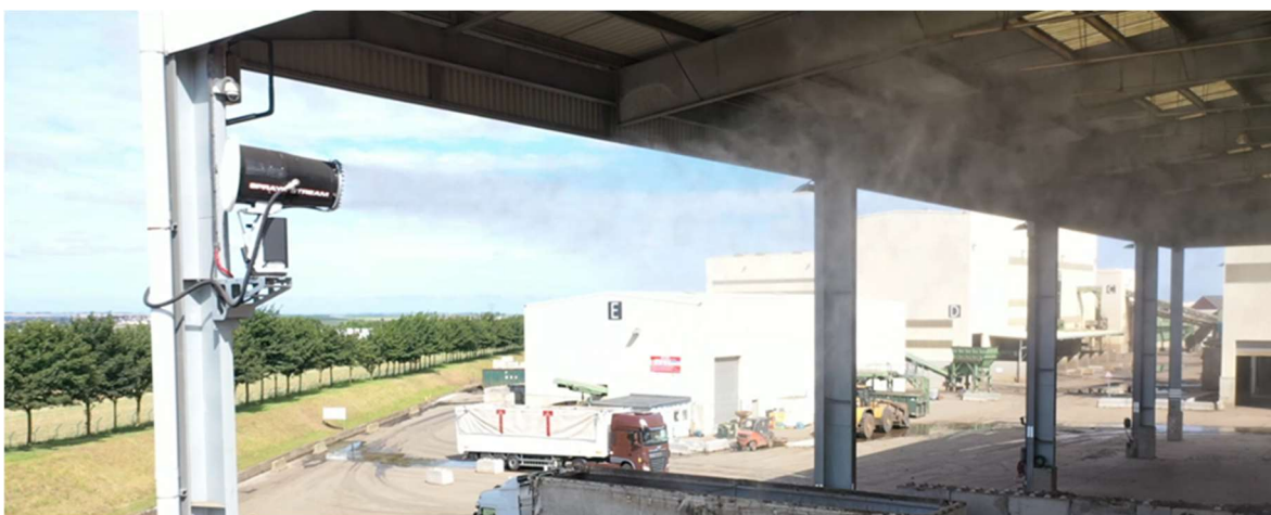
Figure 153 : Chargement et déchargement de camions sur les bâtiments G et A
