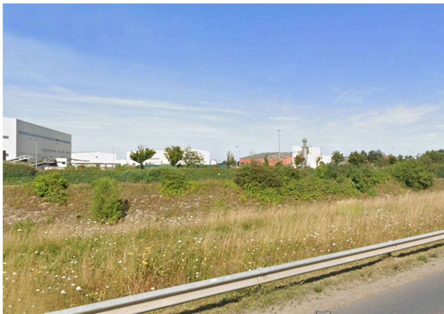
Vue de l'existant
