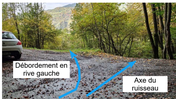
Figure III.24: débordements possibles en rive gauche au franchissement de la piste forestière de Villarnard.
