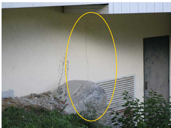
Figure III.40: fissure verticale sur la façade est du bâtiment Saboïa A.
