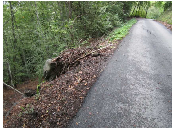
Figure III.53: exemple de bloc pouvant se remettre en mouvement dans la pente.
