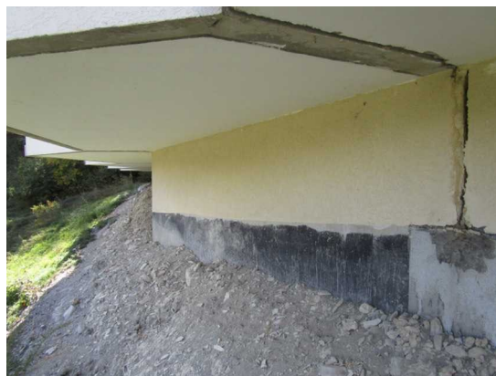
Figure III.41: écartement d'un joint de dilatation (2 à 3cm).
