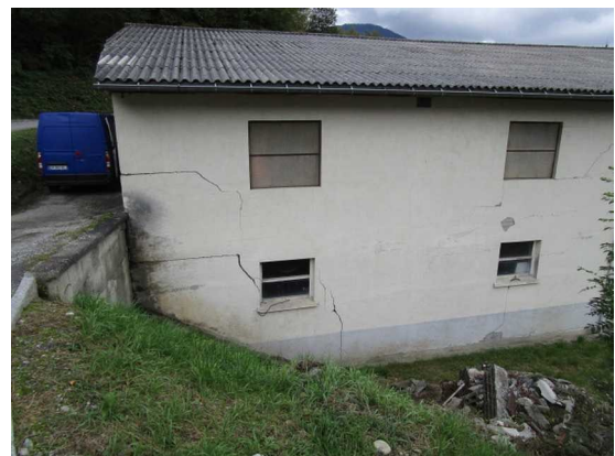
Figure III.52: bâtiment commercial de La Perrière très fissuré.
