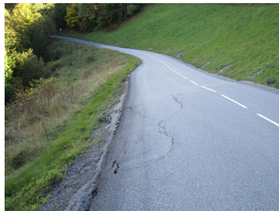
Figure III.42: glissement de terrain à la sortie ouest de la station de La Tania (RD98 très déformée).
