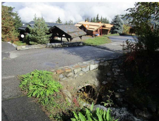
Figure III.9: ponceau à l'amont du village de La Tania franchit par le Praz-Juget. un débordement est possible en rive droite.
