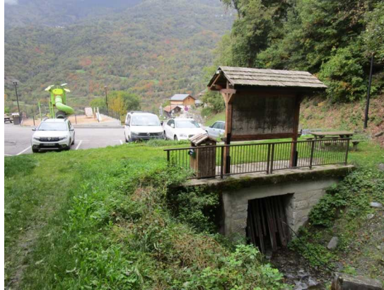
Figure III.26: franchissement de la rue de la Valette par le Nant-David et débordements possibles en rive droite.
