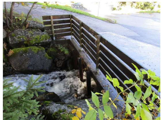
Figure III.16: exemple de piège à matériaux et flottants sur le Praz-Juget au franchissement de la route de l'Étrivaz (petits IPN verticaux).
