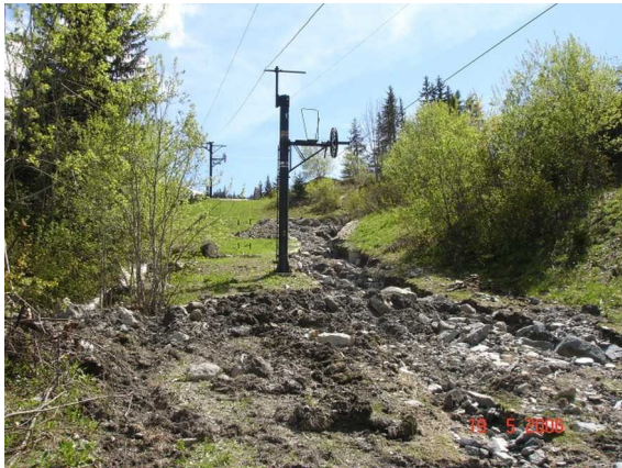
Figure III.14: ravinement de la piste du téléski de Gros-Murger en 2006 par le ruisseau du Nant de La Caille (source RTM 73).
