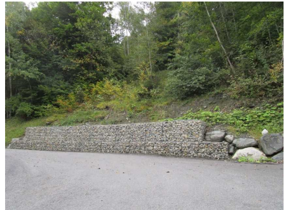
Figure III.50: glissement de terrain et confortement du talus amont de la route de Villarnard.
