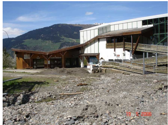
Figure III.15: engravement et inondation de la gare de départ de la télécabine par la crue du Nant de La Caille en 2006 (source RTM 73).
