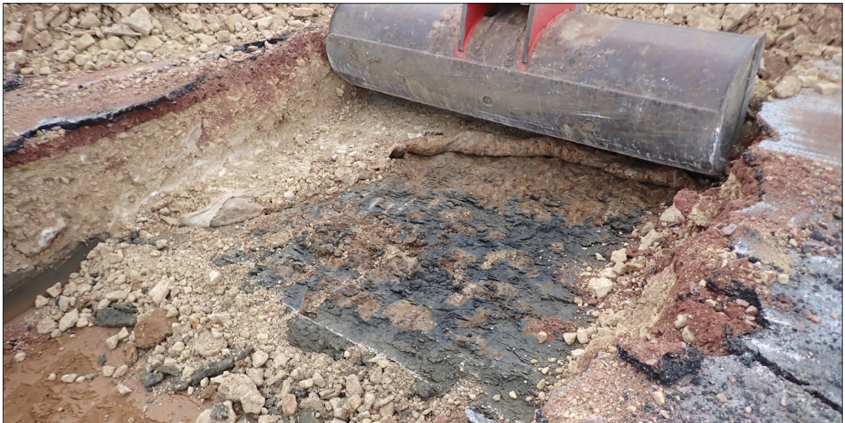
Fig. 19 Enlèvement du géotextile sur le Bt (© A. Vantillard, CD14).
