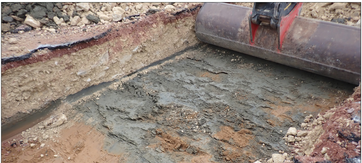
Fig. 20 Altération du Bt sous le géotextile (© A. Vantillard, CD14).
