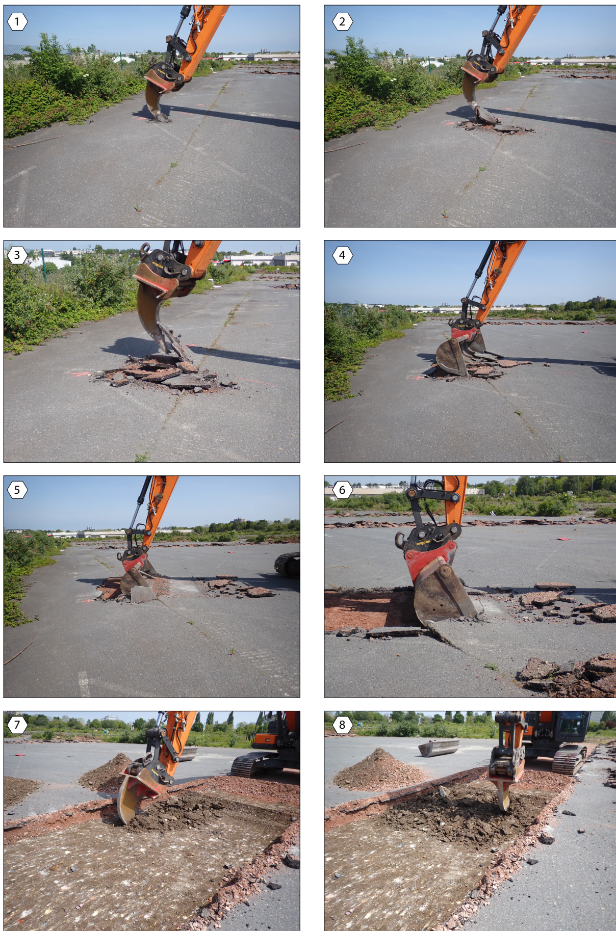
Fig. 9 Méthode d'ouverture des tranchées dans les sols en enrobés (© A. Vantillard, CD14)
