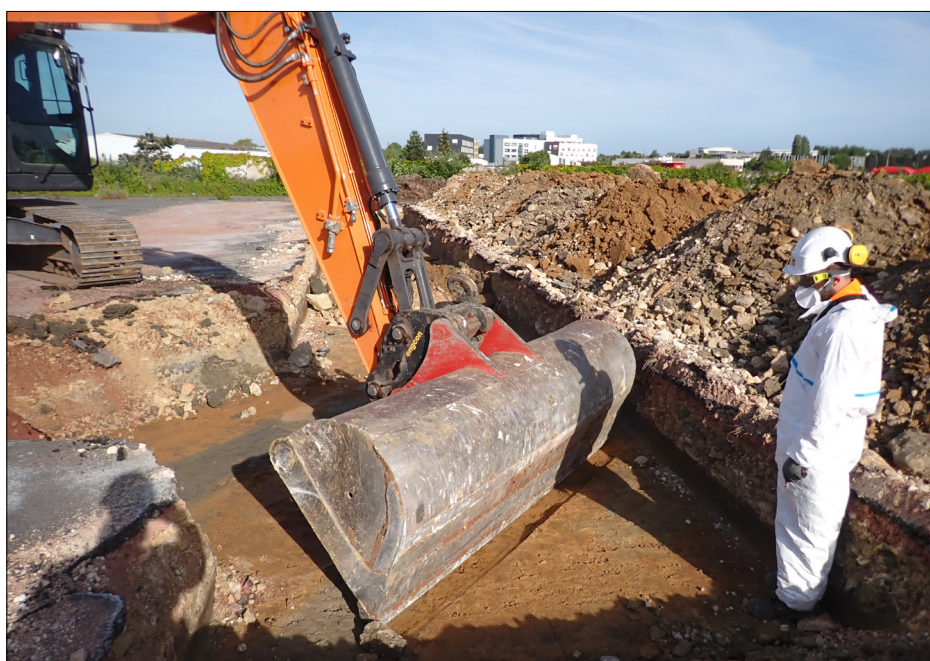
Fig. 10 Décapage en tenue anti-pollution (© L. Caroff, CD14)
