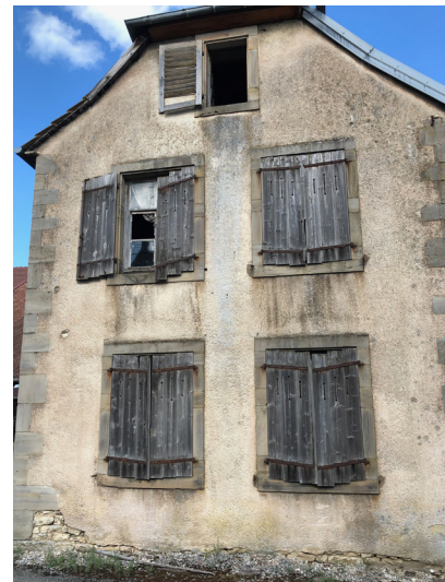
La symétrie des ouvertures en façade est caractéristique d'une construction patrimoniale. Les encadrements des ouvertures et les chaînages d'angle en grès sont des modénatures intéressantes à mettre en valeur.
