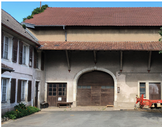
Cette façade accueille une ouverture avec un arc en anse de panier et une porte en bois caractérisant l'architecture rurale et patrimoniale de notre département. Le auvent avec une structure bois rapportée sur des corbeaux est un élément important à conserver. Le bâtiment d'habitation mitoyen accueille également des persiennes et des menuiseries avec petits bois .
