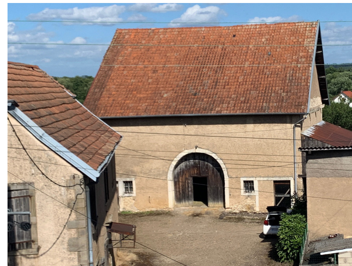
Ce bâtiment dispose de peu d'ouverture. Il a la particularité d'avoir un niveau de rez-de-chaussée surélevé par rapport au sol du terrain côté Est ; cela est une contrainte pour sa réhabilitation. Peu de modénature sont présentes mis à part certains encadrements des ouvertures en grès ou en Pierre de taille .
