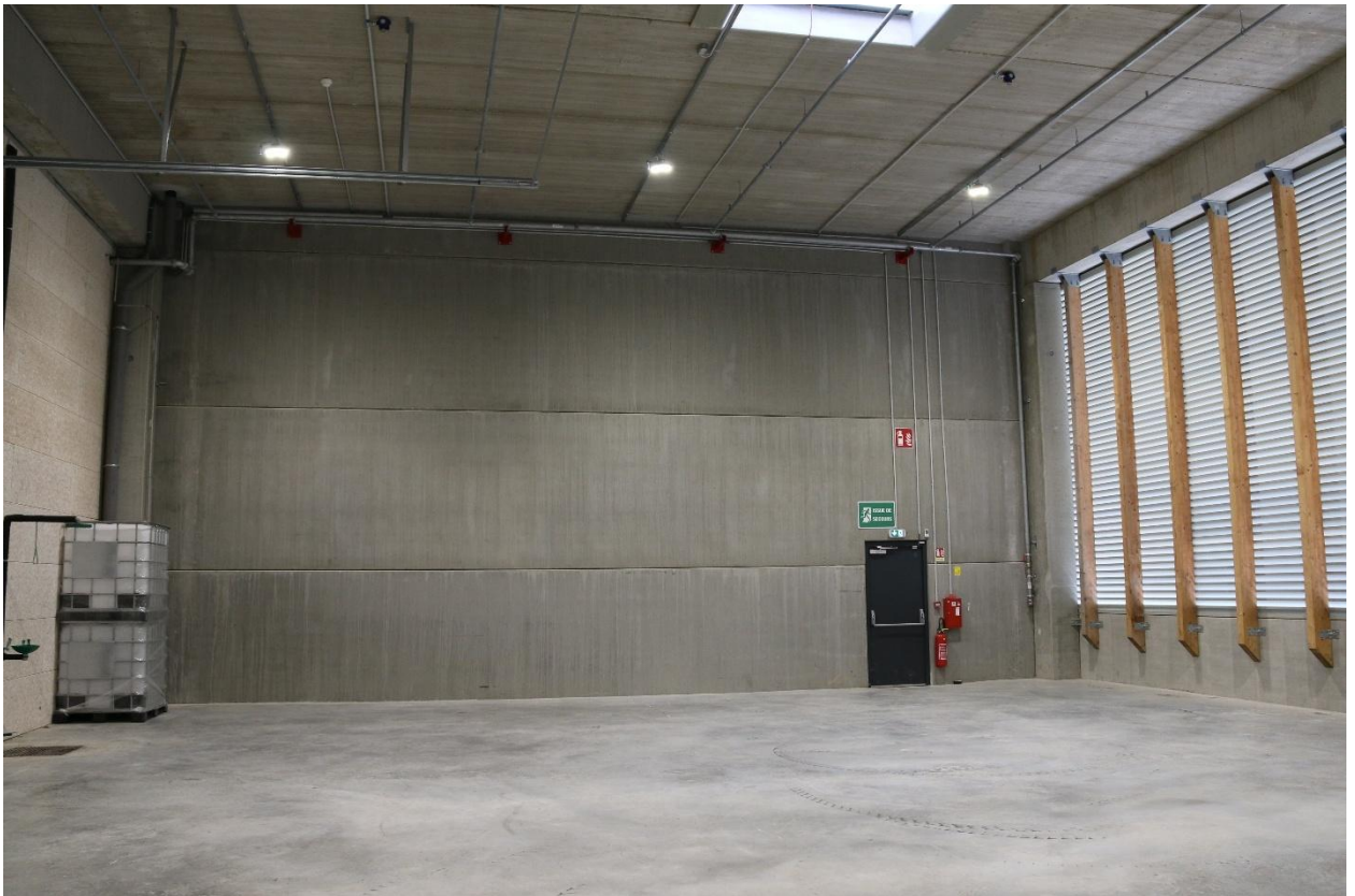
Salle de test des stacks.
