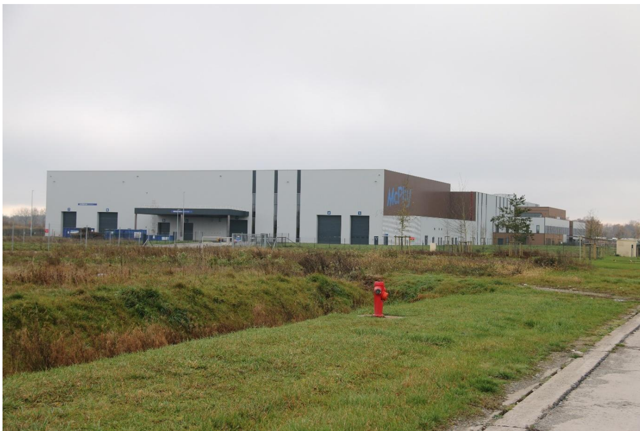
Vue du bâtiment nouvellement édifié et inauguré le 13 juin 2024.
