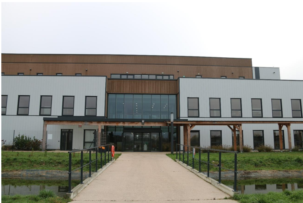
Entrée du bâtiment.
