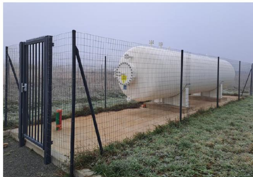
Cuve de stockage de l'hydrogène en extérieur
