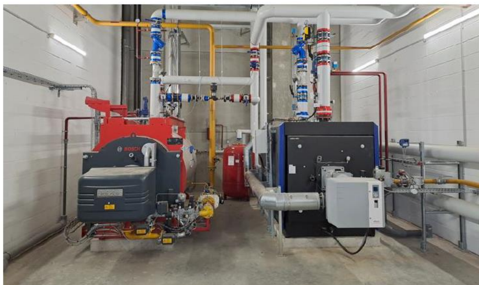
Chaudière Hydrogène
