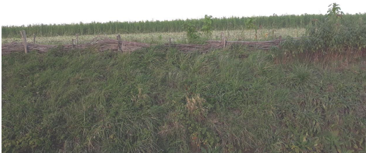
Figure 46 : Fascines installées en amont du chemin de Galfingue
