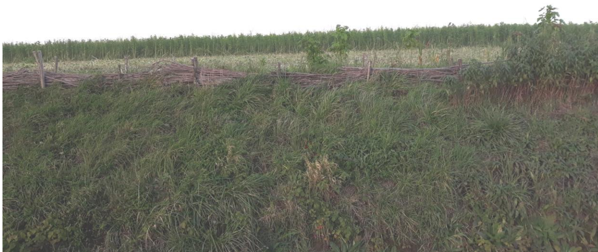
Figure 9 : Fascines installées en amont du chemin de Galfinque
