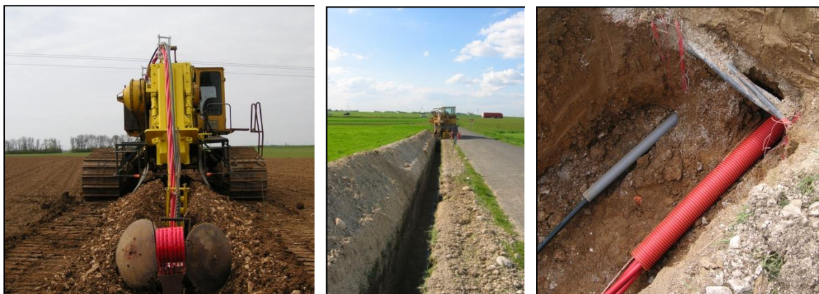
Figure 16 : Photos illustrant l'installation du câblage interne – Source : NORDEX
