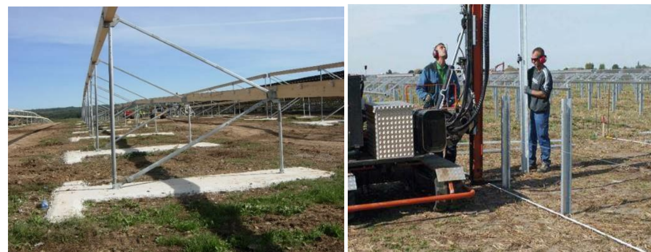
Figure 4 : Structures et fondations longrines (à gauche), pieux battus (à droite)
