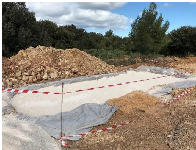
Figure 34 : Fouille préparée pour la pose d'un poste de conversion/transformation
