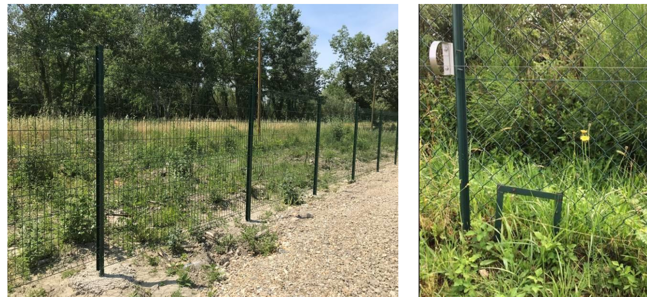
Figure 23 : Exemples de clôture (gauche) et passe-faune (droite) (Source : EDF Renouvelables)
