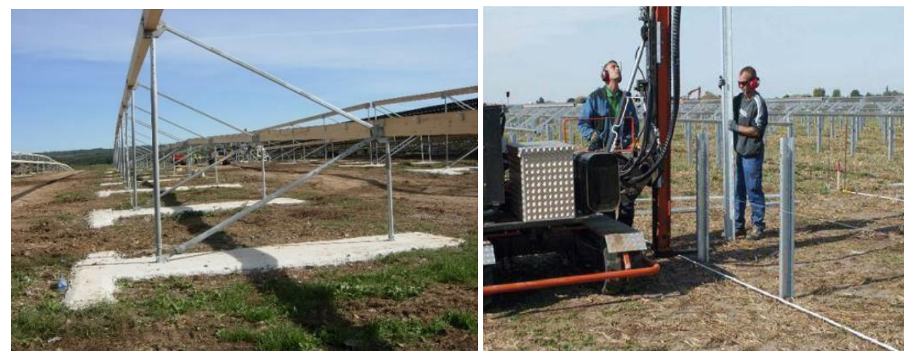
Figure 16 : Structures et fondations longrines (à gauche), pieux battus (à droite) Sources : EDF Renouvelables
