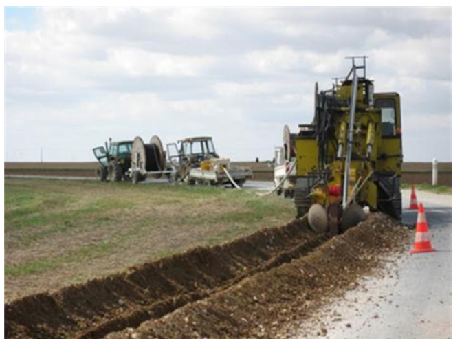
Figure 35 : Réalisation de tranchées du raccordement externe dans l'emprise des voies existantes
