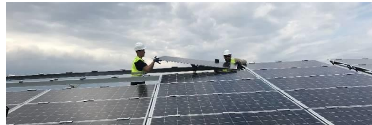
Figure 33 : Pose des modules
