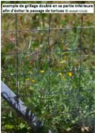
Figure 168: Extrait de la note méthodologique concernant le grillage à utiliser pour délimiter le projet (Source: DREAL Corse)
