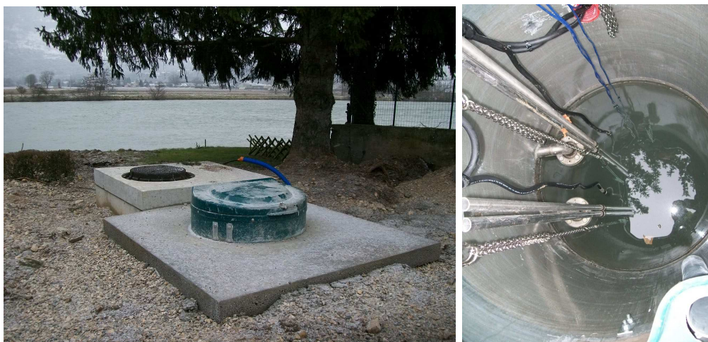
Vues extérieure et intérieure du poste de relevage
