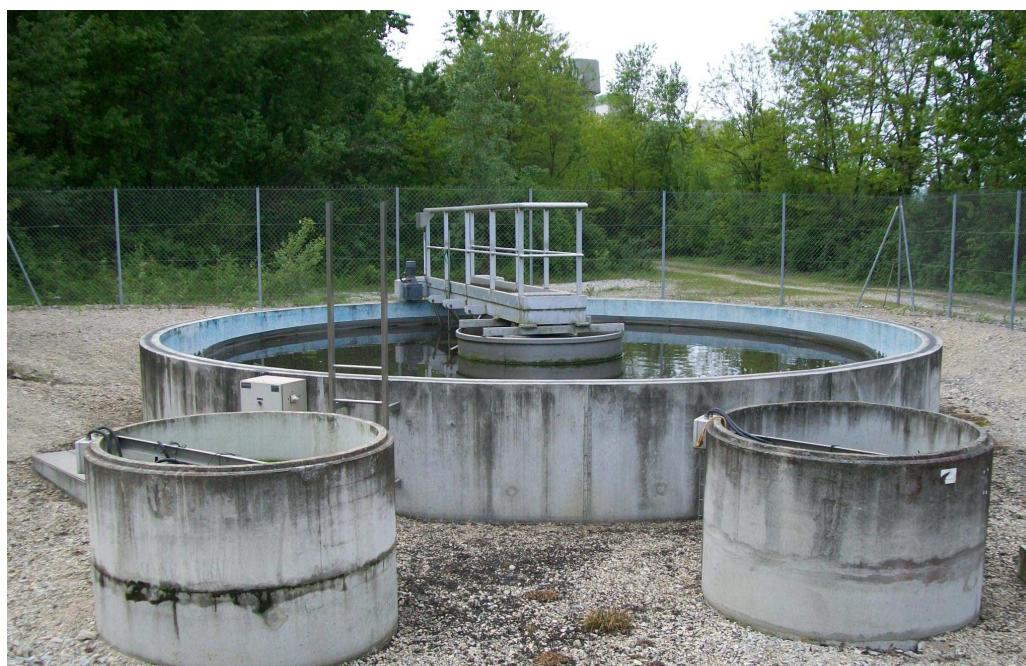
Clarificateur avec postes de recirculation des boues et des effluents
