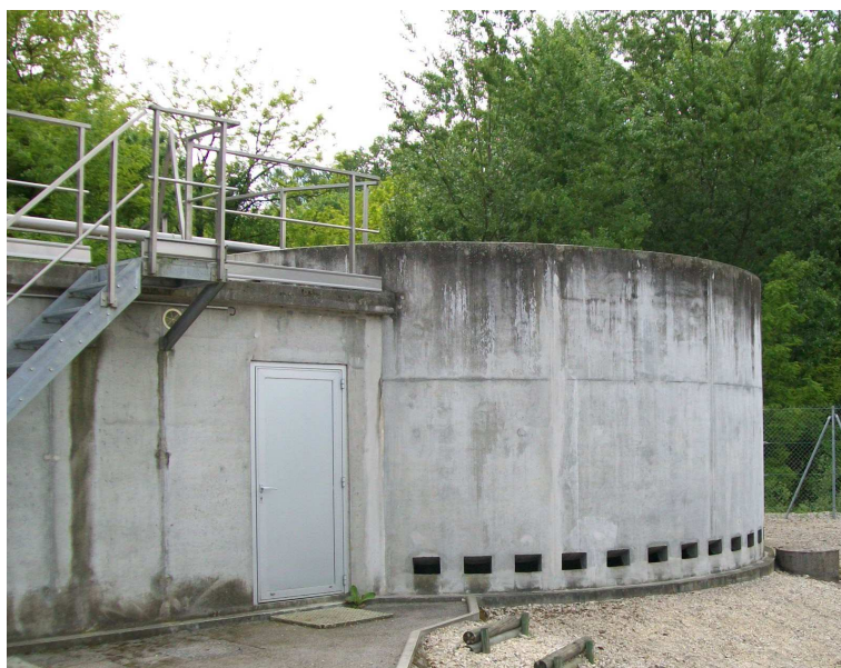
Décanteur et lit bactérien
